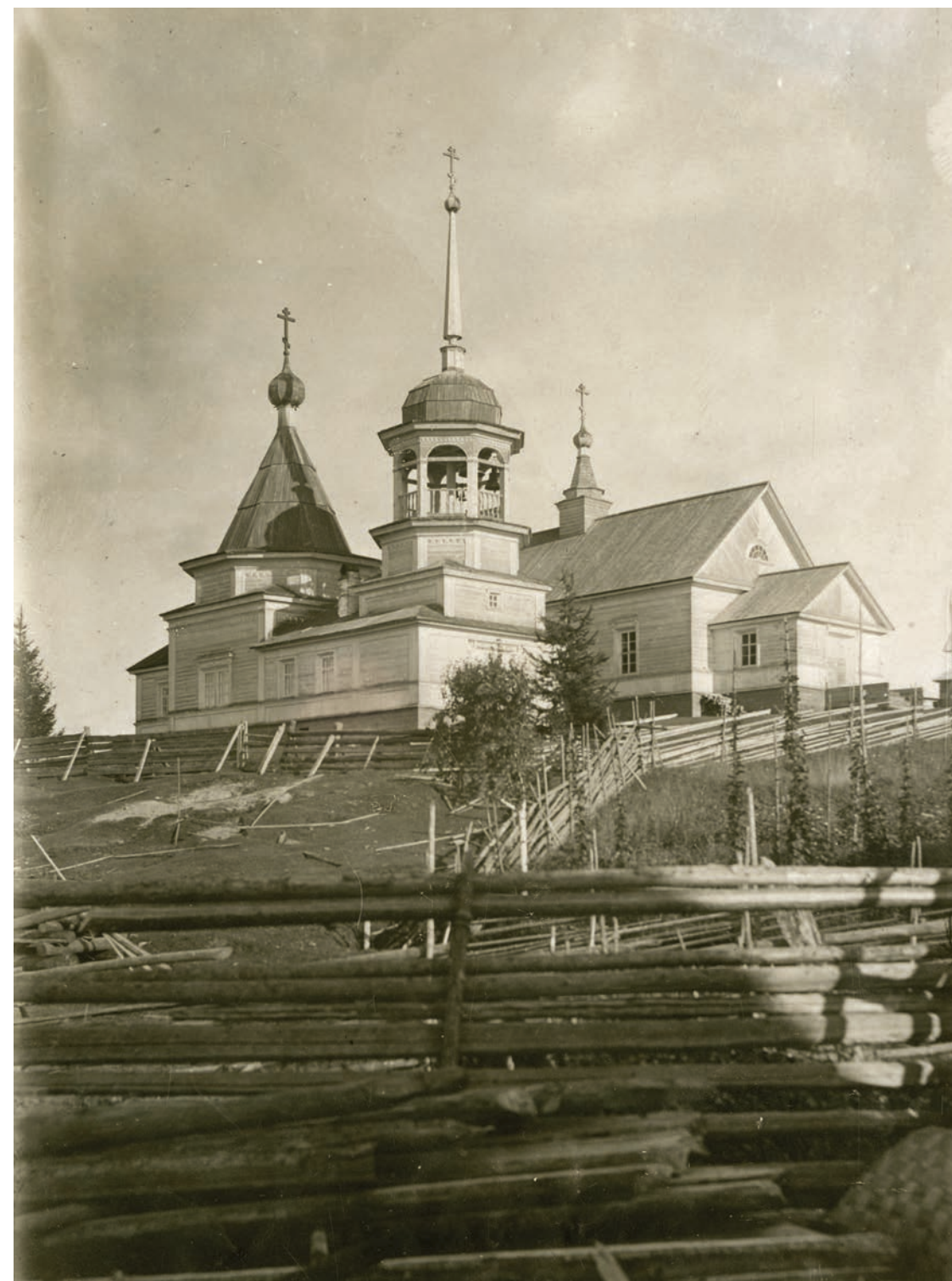
Георгиевская и Ильинская церкви. Фотография П.Д. Барановского, 1931 г. из фондов Музея архитектуры им. А.В. Щусева
