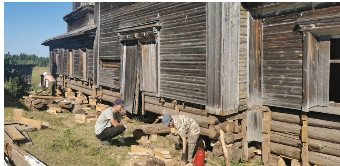
Подъём сруба Георгиевской церкви
